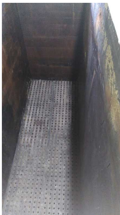
Figure 6 : Vue à l'intérieur d'un bassin Biopur© C vide lors des travaux d'assainissement entrepris au printemps 2023.
